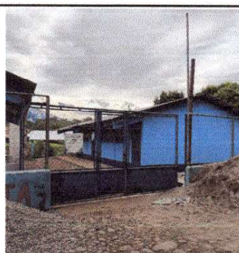
Foto 4: Pintura en muros exteriores e interiores
