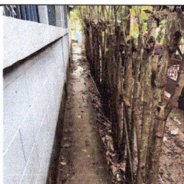
Foto 5: Pintura en muros exteriores e interiores
