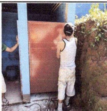
Foto 3: Fabricación e instalación de puertas de metal en baños
